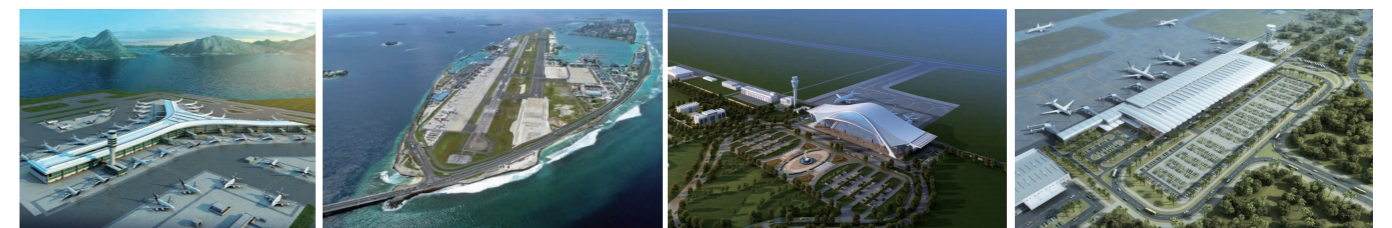
香港国际机场扩建项目
